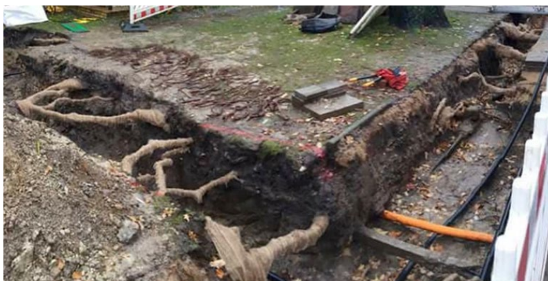
14 pav. Tranšėjos ir lovio kasimo išsaugant medžių šaknis pavyzdys
